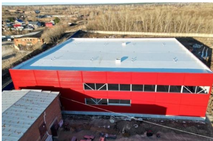
ПРОИЗВОДСТВО ЭЛЕКТРОТЕХНИЧЕСКОЙ ПРОДУКЦИИ
