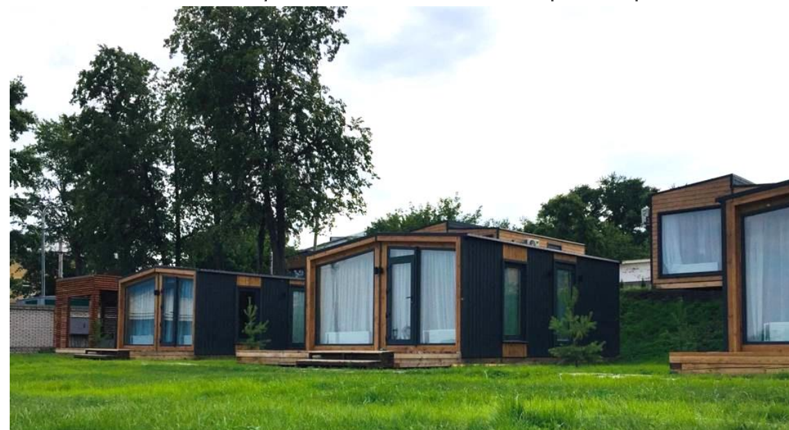
ГОСТИНИЧНЫЙ КОМПЛЕКС «КАСКАД»
