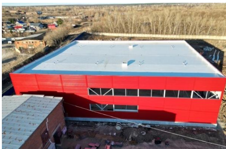
ПРОИЗВОДСТВО ЭЛЕКТРОТЕХНИЧЕСКОЙ ПРОДУКЦИИ
